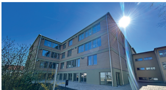
Der Anbau ist vom Bestandsgebäude aus auf allen Ebenen erreichbar.
