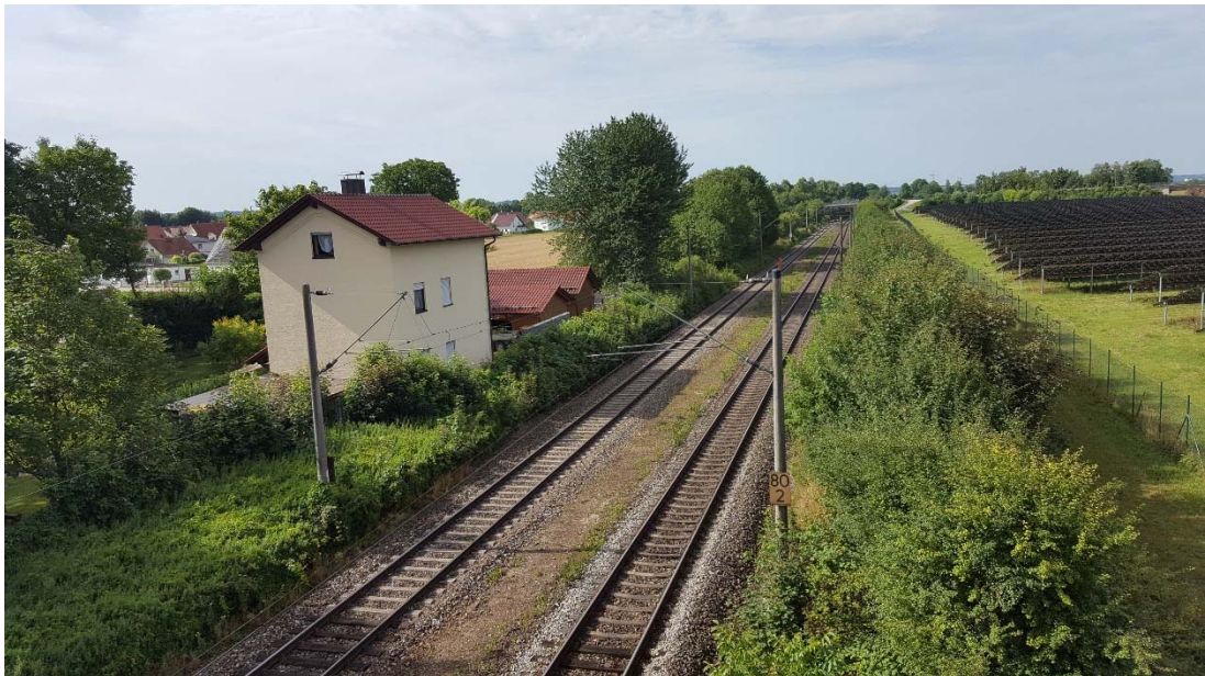
Gehölzstrukturen entlang der Bahnlinie (Biotopkartiert, außerhalb des Geltungsbereichs)
